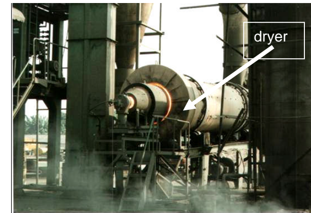
Gambar 12. Agregat dikeringkan dengan pemanasan di dalam dryer
