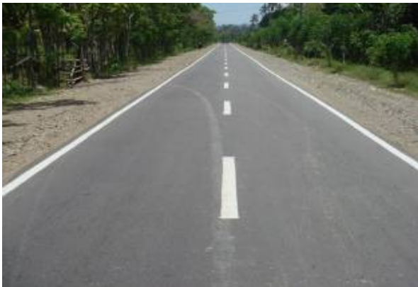
Perkerasan Jalan Campuran Beraspal Panas dengan Bahan Tambah Asbuton di Gorontalo
