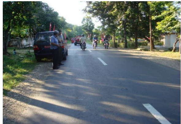
Perkerasan Jalan Campuran Beraspal Panas dengan Bahan Tambah Asbuton di Sulawesi Tenggara
