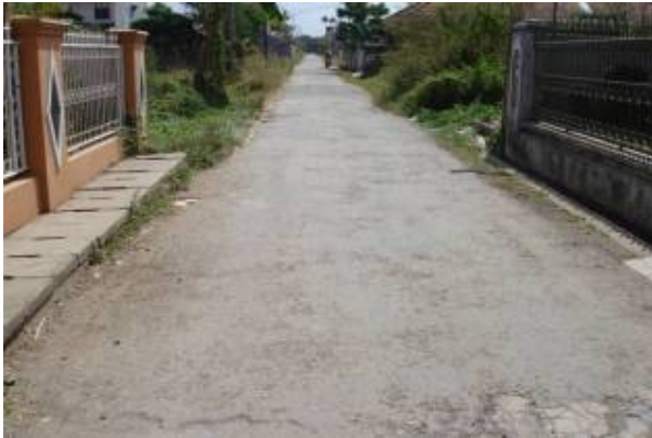
Perkerasan Jalan Lingkungan dengan Lapis Penetrasi Mastik Asbuton di Bandung Jawa Barat
