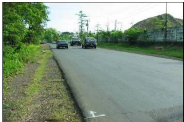
Perkerasan Jalan Campuran Beraspal Panas Asbuton dengan Peremaja Oily Sludge Non Parafinik di Tomo Jawa Barat
