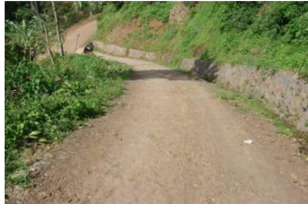
Perkerasan Jalan Lingkungan dengan Lapis Penetrasi Mastik Asbuton di Sumedang Jawa Barat
