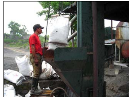
b. Asbuton dimasukkan ke mixer lewat elevator
