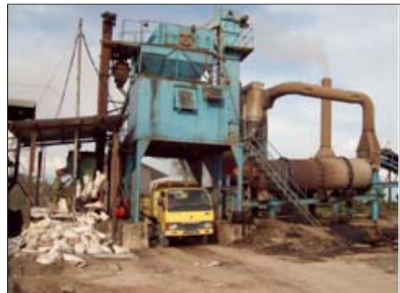
Pencampuran asbuton hangat di AMP
