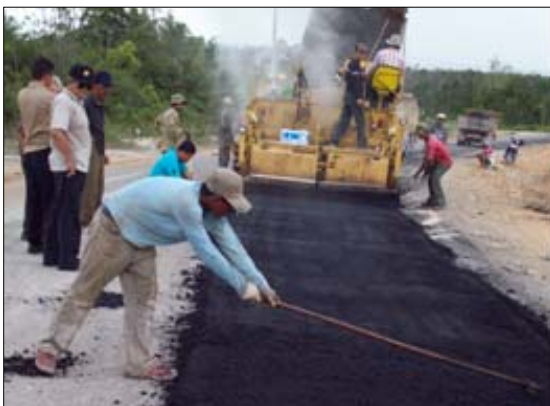
Pelaksanaan penghamparan dilapangan
