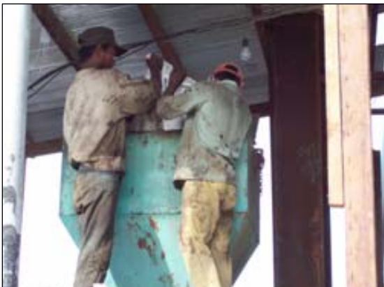
Pemasukan asbuton butir lewat elevator
